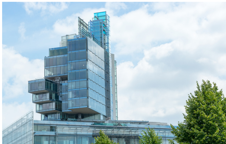
DAS NORD/LB-HAUPTGEBÄUDE IN HANNOVER.
